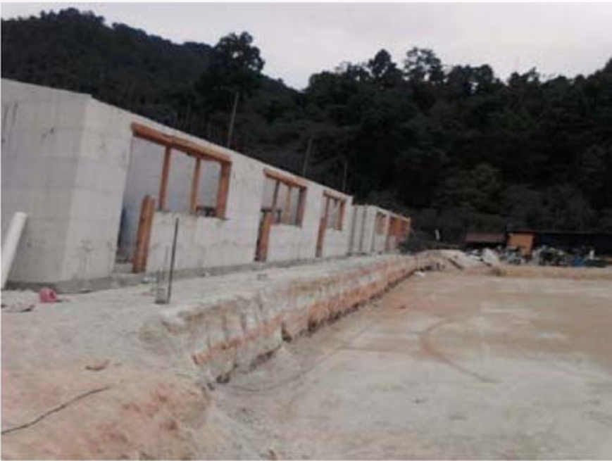
AVANCE EN LA CONSTRUCCIÓN DE LA SECUNDARIA.
