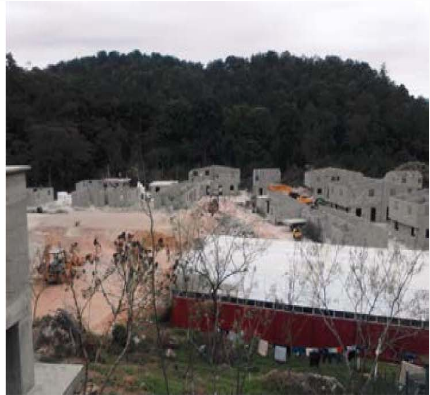
VISTA DE LAS VIVIENDAS QUE OCUPARAN LOS HABITANTES DE LA LOCALIDAD DE LA PINTADA.
