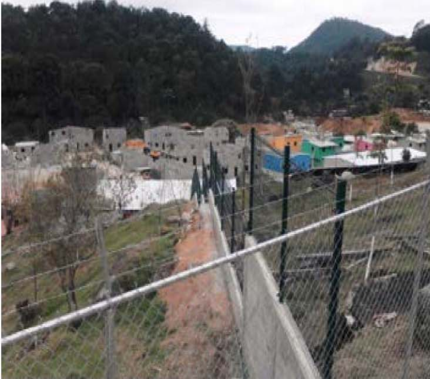
VISTA PANORAMICA DE LOS AVANCES EN LA PRIMERA ETAPA DEL CONJUNTO HABITACIONAL.
