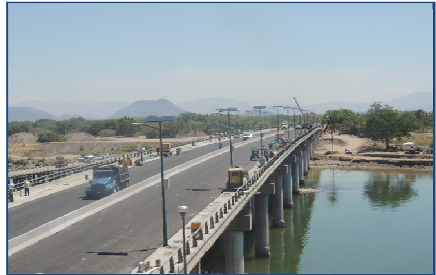
Se colocó parapeto metálico.
