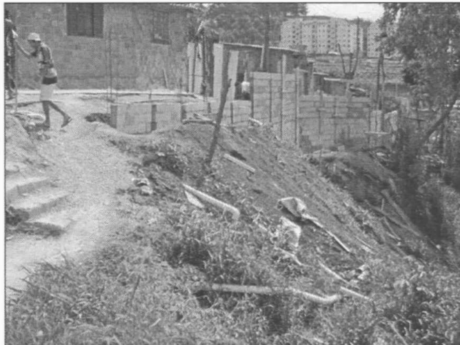
Figura 8. Fotografia de campo. Muro que estava sendo construído para estabilização do local.
