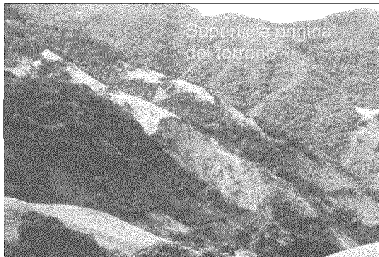
Fig. 2.1 Deslizamiento Quebradas, Santa Ana, Costa Rica, se aprecia la superficie original del terreno (Foto R. Mora).
