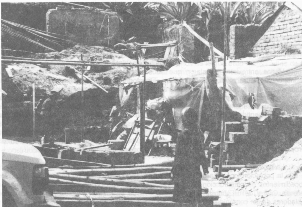
FIGURA 7.4 Alojamiento temporal de cubiertas de plástico usadas como residencial mientras la familia construye una nueva casa empleando una estructura de metal en Tabacundo, Provincia de Pichincha.
