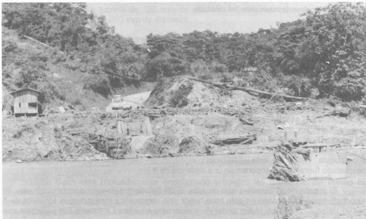
FIGURA 6.4 Oleoducto trans-ecuatoriano al O del río Aguarico empujado hacia el Sur por la inundación. Nótese el pilar remanente y la cimentación del puente en la ribera.
