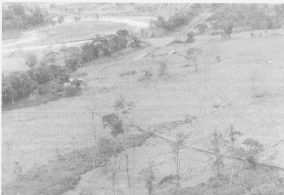
FIGURA 6.9 Planicie de un gran flujo de escombros con el oleoducto trans-ecuatoriano deformado en la dirección del movimiento.
