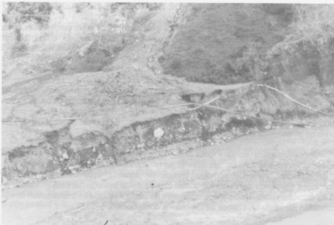
FIGURA 6.8 Tuberías del oleoducto y poliducto (en blanco) trans-ecuatorianos interrumpidas por flujos de escombros y erosión profunda a lo largo del río Coca.
