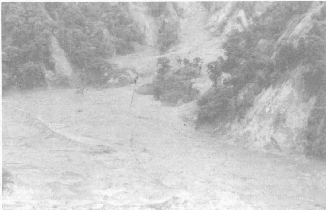
FIGURA 6.7 Inundación a lo largo del río Coca. Nótese la tubería rota y deformada al lado izquierdo de la fotografía.
