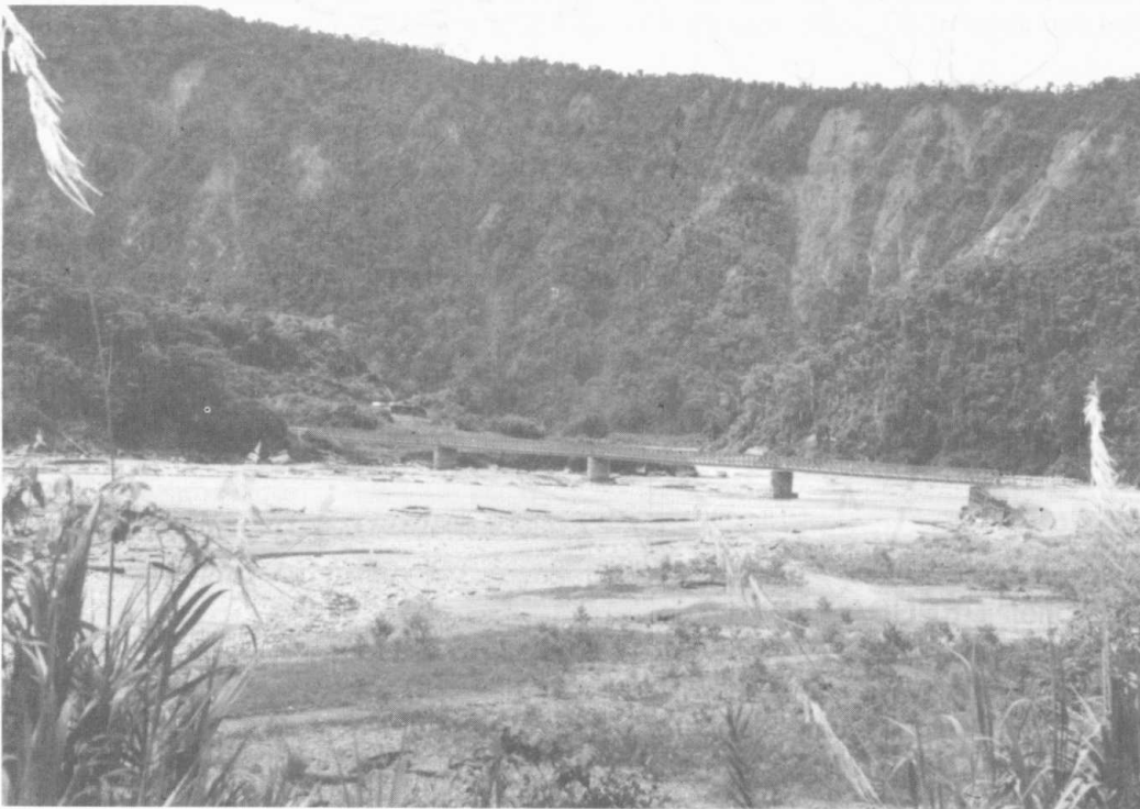
FIGURA 5.9 C Vista en Junio de 1990 de las mismas paredes del valle mostrando un recubrimiento parcial de la vegetación en las cicatrices de los deslizamientos de 1987. Nótese el puente reconstruido de la carretera trans-ecuatorial cruzando el río Salado.
