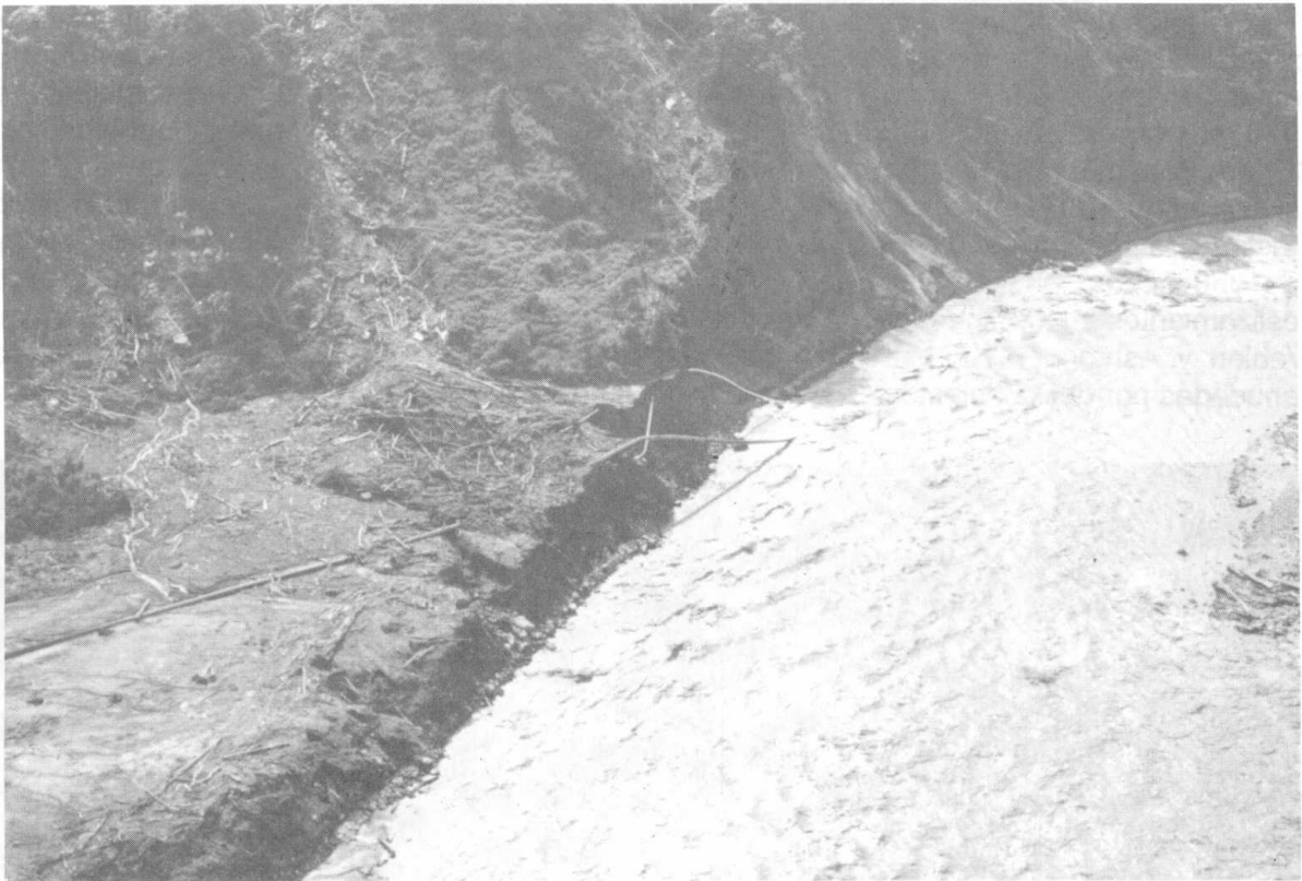
FIGURA 1.9 Destrucción del oleoducto trans-ecuatoriano y la carretera por la erosión provocada por el aluvión en la margen izquierda del río Coca como resultado de los terremotos del 5 de Marzo de 1987.
