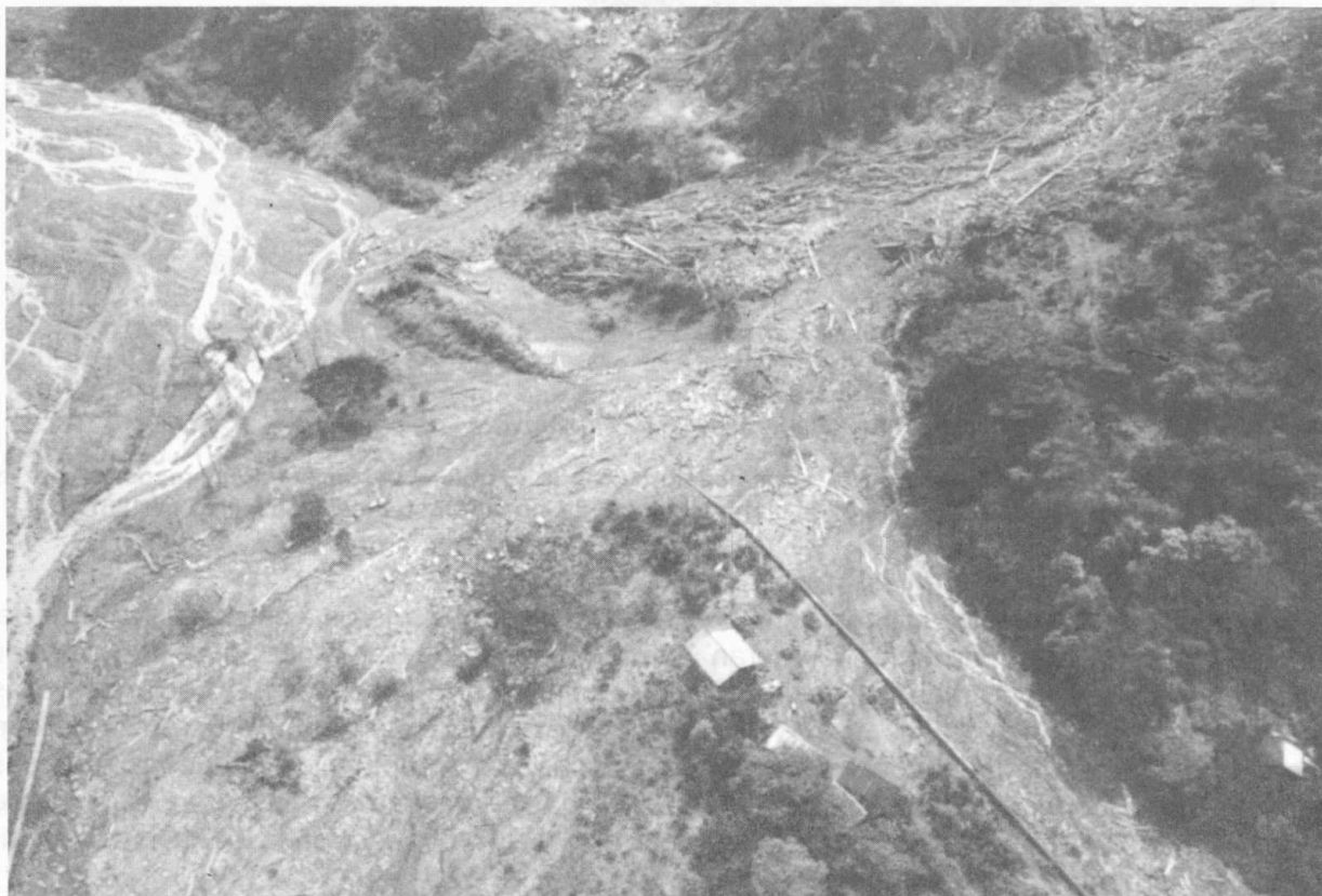
FIGURA 1.8 Vista aérea de la destrucción del oleoducto trans-ecuadoriano y la carretera adyacente por un flujo de escombros descargado por un tributario menor del río Coca. La localidad es cercana a la boca del río Reventador.
