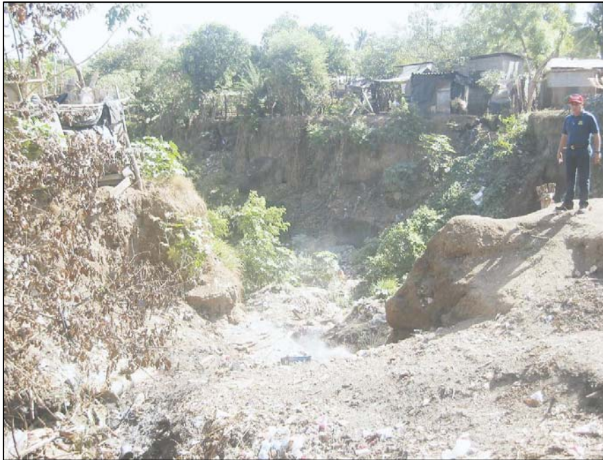
Lámina 1: Población asentada en zona de Riesgo.
