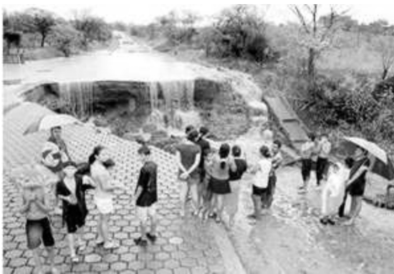
Derrumbe en carretera de Villa El Carmen, municipio de Managua, a causa de lluvias provocadas por ondas tropicales en Mayo, 2003.
