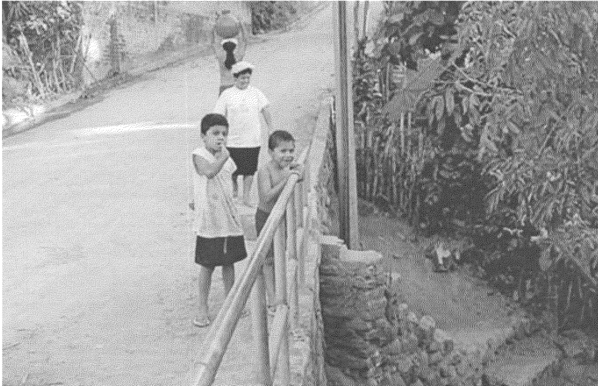
Figura 21 Puente y cárcava reparada en San Pedro Nonualco
