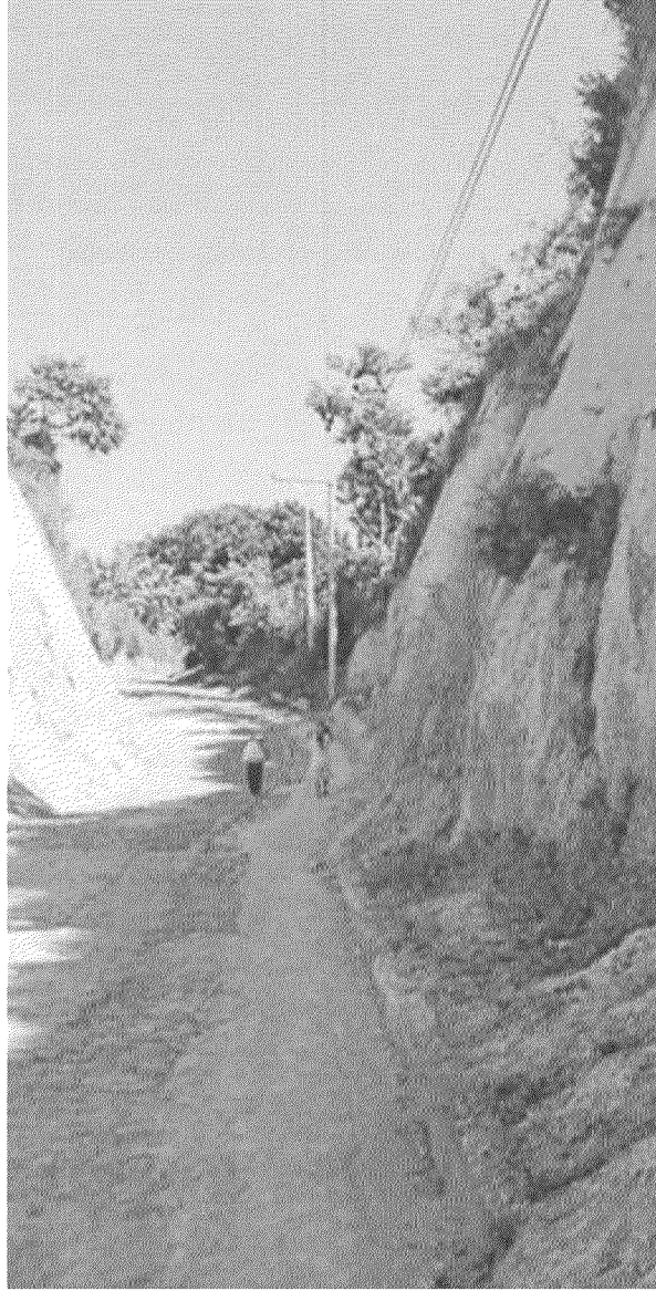
Figura 2: Camino típico vecinal con amenaza permanente de deslizamiento causado por el relieve accidentado en el área de intervención del proyecto
