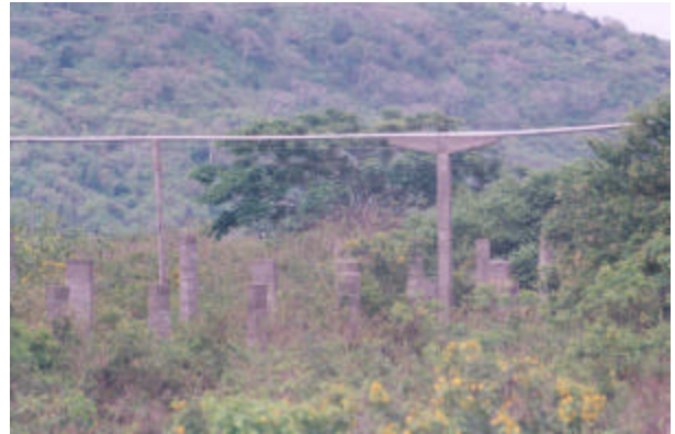
Fotos 62. Estructura de hormigón armado para conducir el agua entubada. Sistema de comunidades rurales. Sector: Las Chacras - Montecristi. Marzo 2000. Fuente: Macias, Ramón.
