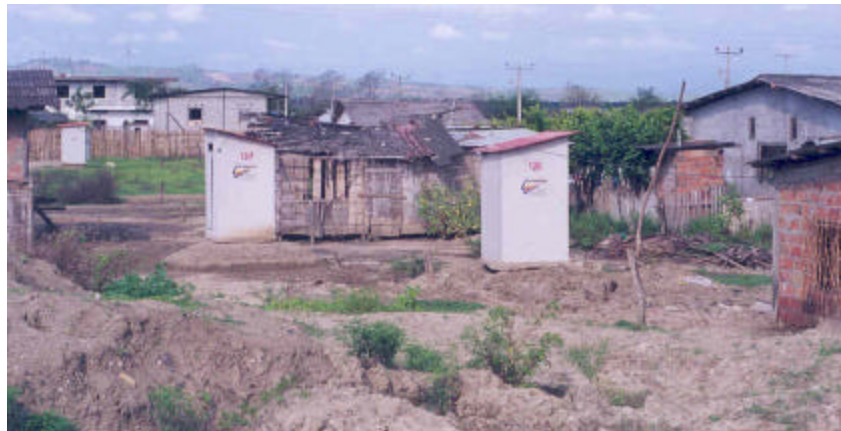
Fotos 63. Sistema de saneamiento ambiental mediante letrinas en la comunidad de San Agustín Km-20, se observan los sedimentos que cubrieron hasta 2 metros de altura en la población. Sistema de comunidades rurales. Sector: San Agustín Km. 20- Bahía de Caráquez. Enero 2000. Fuente: Macias, Ramón.
