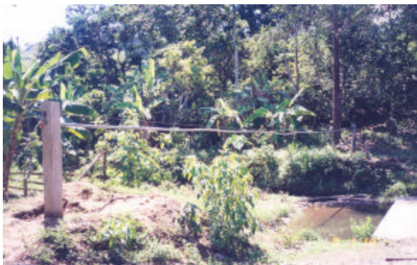
Foto 58. Construcción de paso aéreo sobre el estero. Sistema de comunidades rurales Sector: Andariel - Junín. Julio 2000. Fuente: SSA. Pico, Jaime.
