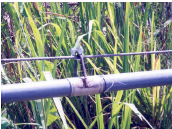
Foto 60. Detalle del paso elevado de la tubería en un paso aéreo. Sistema de comunidades rurales. Sector: Andariel. Agosto 1999. Fuente: SSA. Pico, Jaime.
