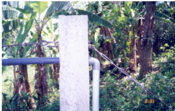
Foto 59. Estructura de hormigón armado y tubería de paso aéreo. Sistema de comunidades rurales. Sector: Andariel. Agosto 1999. Fuente: SSA. Pico, Jaime
