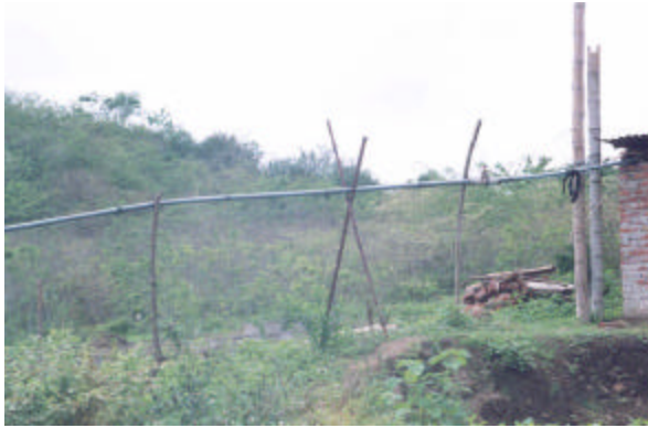
Fotos 61. Estructura de materiales locales para sortear esteros y evitar que la tubería sea arrastrada por las aguas, simulando pasos aéreos. Sistema de comunidades rurales. Sector: Bajos de las Palmas- Montecristi. Marzo 2000. Fuente: Macias, Ramón.
