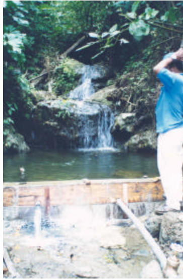
Foto 57. Construcción de nueva captación superficial. Sistema de comunidades rurales. Sector: Estero de Bonce-Comunidad Bonce-Santa Ana. Marzo 2000. Fuente: SSA. Pico, Jaime
