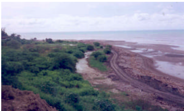
Foto 53. En la foto se muestra la carretera por donde cruza la tubería y el peligro constante del mar.. Sistema de Esmeraldas - línea de conducción a Camarones. Sector: línea en construcción. Tacuza-camarones, zona del ramal norte. Julio 1999. Fuente: SSA. Empresa fiscalizadora Narváez F. y Correa, M.
