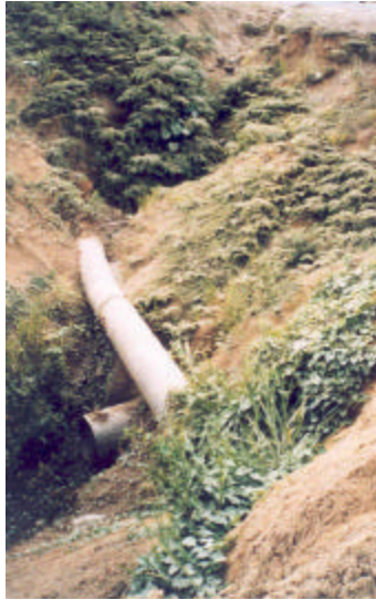
Foto 40. Segundo cruce de quebrada en “La Batea”, en este sitio el bloque de anclaje fue destruido. Sector: carretera a Esmeraldas. Octubre 1998. Fuente: OPS, Rodríguez, A.
