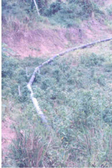
Fotos 47. Tubería soldada y colocada sobre marcos H. Sector: Espaldón del diablo. Febrero2000. Fuente: Macias, Ramón
