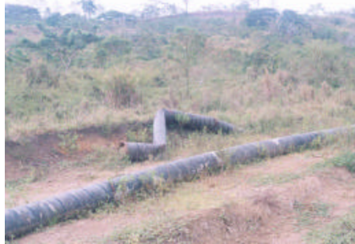
Foto 41. Al fondo se puede observar la tubería de acero deformada y destruida por los deslizamientos de tierra y la tubería de acero colocada superficialmente. Sector: “Canta Rana”. Febrero 2000. Fuente: OPS, Rodríguez, A
