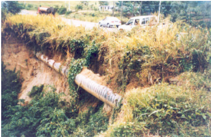
Foto 39. Cruce de quebrada “La Batea”. La tubería que estaba enterrada se encontraba expuesta y desprotegida. Sector: carretera a Esmeraldas Octubre 1998. Fuente: OPS, Rodríguez, A.
