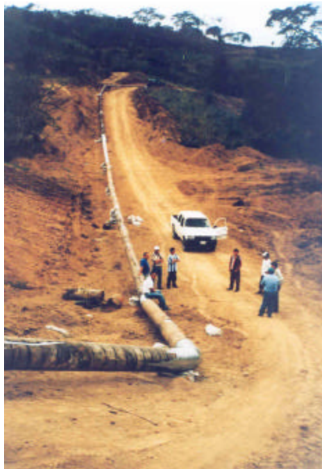
Foto 45. Tubería recuperada, la misma que ha sido desplazada por deslizamientos. Sector: Túnel #1 y Túnel #2. Octubre 1998. Fuente: OPS, Rodríguez, A
