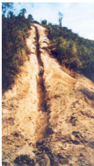
Foto 56 .Tramo con alta pendiente y suelos inestables en la línea de conducción hacia Camarones- Achilube. Sistema de Esmeraldas - línea de conducción a Camarones Achilube. Sector: línea en construcción Camaron es- Achilube. Octubre 1998. Fuente: OPS, Rodríguez, A.
