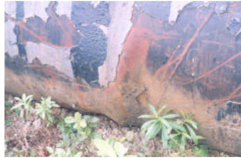
Fotos 36. Tubería de acero de 600 mm. colocada sobre la superficie del suelo, se observa el estado de deformación y oxidación. Sector: Villas de Petroecuador, derivación 900-600 mm. Febrero 2000. Fuente: Macias, Ramón .
