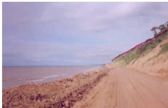
Foto 54. En la foto se señala el lugar por donde se cambió la ruta de la tubería para evitar que sea socavada por la marea.. Sistema de Esmeraldas - línea de conducción a Camarones. Sector: línea en construcción. Tacuza-camarones, zona de la playa. Julio 1999. Fuente: SSA. Empresa fiscalizadora Narváez F. y Correa, M.
