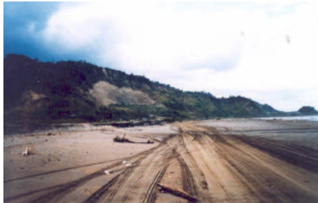
Foto 52. Zona de la playa en la que se colocaría inicialmente la tubería.. Sistema de Esmeraldas - línea de conducción a Camarones. Sector: línea en construcción. Octubre 1998. Fuente: OPS, Rodríguez, A .
