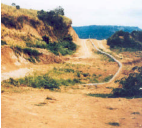
Foto 38. Tramo que corre el riesgo que fallar en la línea de conducción a Esmeraldas. Sector: Villas de Petro Ecuador, derivación 900-600 mm. Octubre 1998. Fuente: OPS, Rodríguez, A.
