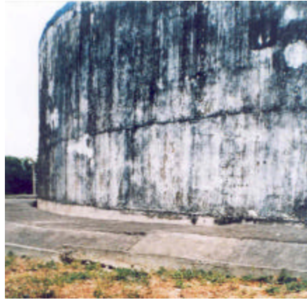
Foto 50. Tanque de Atacames, es importante observar el desplazamiento vertical de la acera, con respecto a la estructura del tanque. La destrucción de la cuneta y la grieta en el terreno son evidentes. Sector: Tanque de reserva de Atacames. Octubre 1998. Fuente: OPS Rodríguez, A
