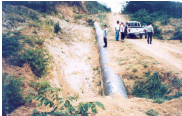
Foto 37. Tubería reparada en la línea de conducción hacia Esmeraldas. Obsérvese el espacio a la izquierda del tubo para recibir y posteriormente remover material de deslizamientos. Sector: Winchele. Octubre 1998. Fuente: OPS, Rodríguez, A.
