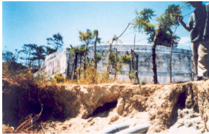
Foto 48. Terreno erosionado cerca del tanque #4, y la tubería que antes estaba enterrada, y ahora expuesta. Sector: ciudad de Esmeraldas. Octubre 1998. Fuente: OPS, Rodríguez, A.
