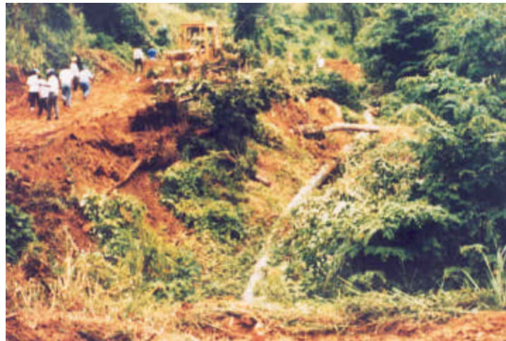
Fotos 46. Tubería de acero desplazada y deformada por un deslizamiento en la conducción a Atacames, entre el Espaldón del diablo y el túnel # 3. Sector: Espaldón del diablo y el túnel # 3. Octubre 1998. Fuente: OPS, Rodríguez, A
