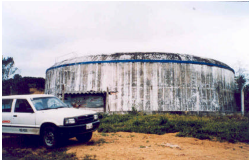
Foto 49. Tanque de Tonsura. Nótese a la derecha el desajuste de la cúpula del tanque. Sector: Tanque de reserva de Tonsura. Octubre 1998. Fuente: OPS, Rodríguez, A
