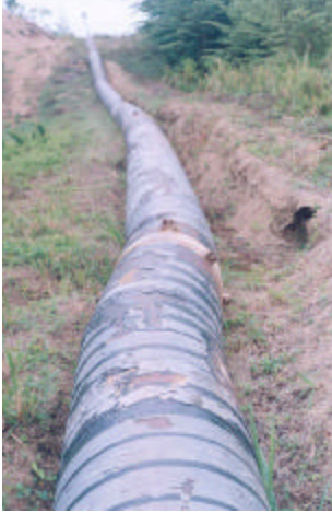
Fotos 36. Tubería de acero de 600 mm. colocada sobre la superficie del suelo, se observa el estado de deformación y oxidación. Sector: Villas de Petroecuador, derivación 900-600 mm. Febrero 2000. Fuente: Macias, Ramón .
