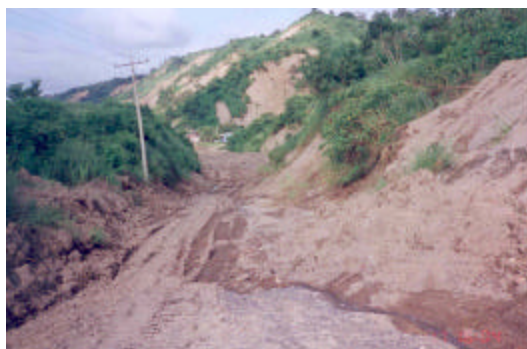
Foto 55. Tramo por donde cruza la tubería.. Sistema de Esmeraldas - línea de conducción a Camarones. Sector: línea en construcción Camarones - Achilube. Agosto 1999. Fuente: SSA. Empresa fiscalizadora Narváez F. y Correa, M.
