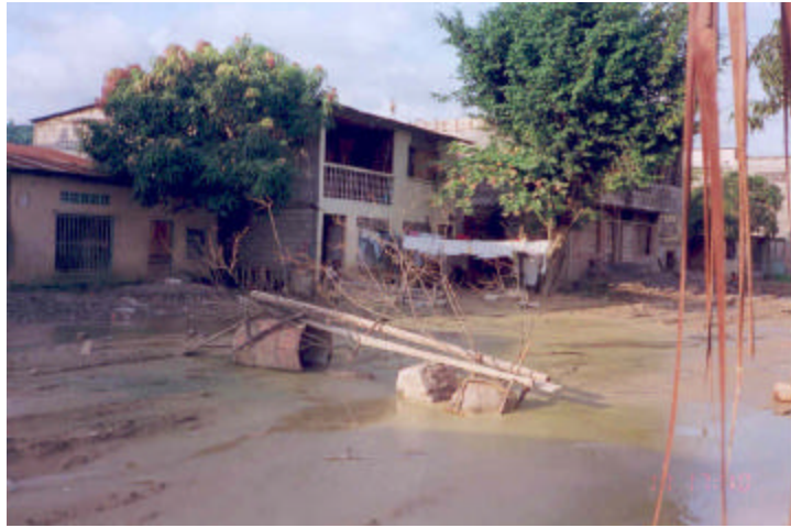
Foto 57. Se observa los sedimentos productos de la erosión del suelo que ayudo a destruir el sistema de alcantarillado. Sector : Esmeraldas- barrio CODESA. Marzo 1998. Fuente: SSA, empresa fiscalizadora. Narváez, F., y Correa, M.
