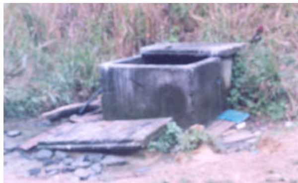
Foto 43 Cámara de válvula de aire que es mal utilizada por los habitantes del sector, ya que permanentemente escapa agua, lo que hace que el suelo se sature y aumente el peligro de deslizaves. Sector: "Costilla del diablo". Febrero 2000. Fuente: Macías, Ramón.
