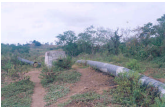
Foto 42. Tubería recuperada y soldada, se observa el anclaje y tubería destruida. Sector: "Costilla del diablo". Febrero 2000. Fuente: Macías, Ramón.
