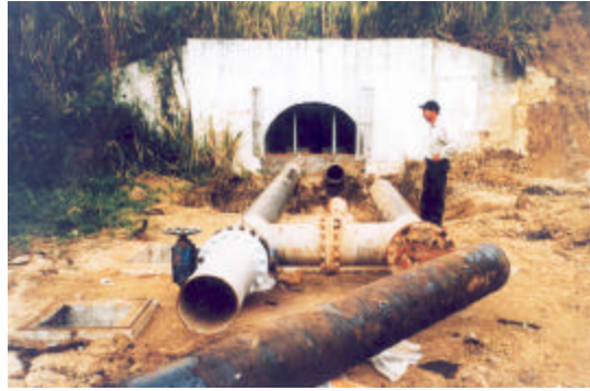
Foto 44. Salida del túnel # 1 cuando se estaba reparando la línea. Sector: Túnel #1. Octubre 1998. Fuente: OPS, Rodríguez, A.
