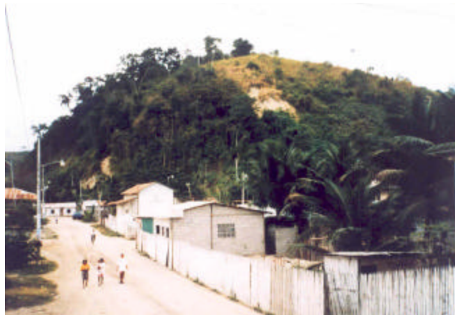
Foto 51. Ladera sobre la cual se ubica el tanque de Atacames, se observa la fuerte pendiente y los deslizamientos existentes. En la parte inferior se muestran las viviendas que se afectarían ante el riesgo de fallar la estructura. Sector: Tanque de reserva de Atacames. Octubre 1998. Fuente: OPS, Rodríguez, A
