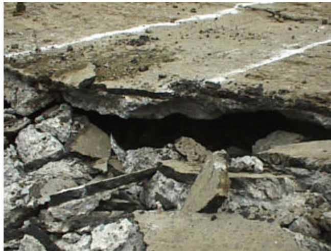
Foto 27. Pavimento destruido y asentamiento del suelo como producto de la rotura de una tubería de aguas servidas. Sector: calle Alajuela y Avenida Manabí. Marzo 2000. Fuente: INA-BRONCO, Zambrano, Tito
