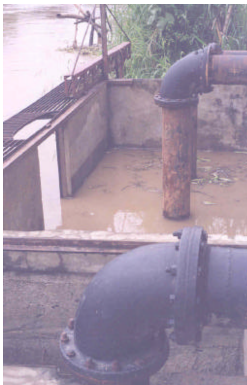
Foto 14. Captación de agua cruda en la estación de bombeo Las Pulgas, en el río Portoviejo. Sector estación de bombeo Las Pulgas. Febrero 2000. Fuente: Macias, Ramón
