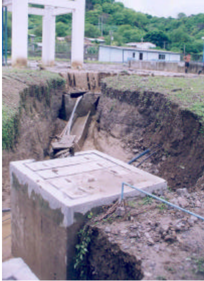
Foto 20. Se aprecia en el cauce del canal El Zapallo las tuberías de químicos y cámaras de válvula. Sector planta de tratamiento de AA.PP.4 Esquinas . Febrero 1998 . Fuente: DCP-CRM Cadena LC.
