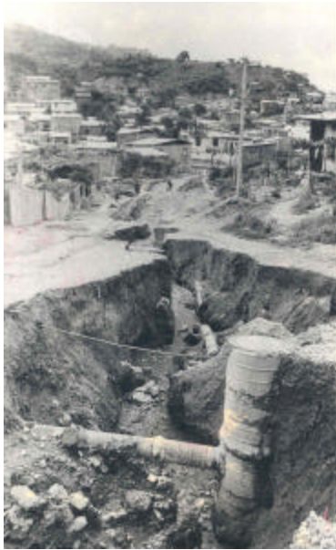
Foto 25. Destrucción de las instalaciones sanitarias provocada por las lluvias durante ENOS 1997-1998. Sector laderas de Andrés de Vera- Portoviejo. Marzo 1998 Fuente: Defensa Civil, Mendoza Roque.
