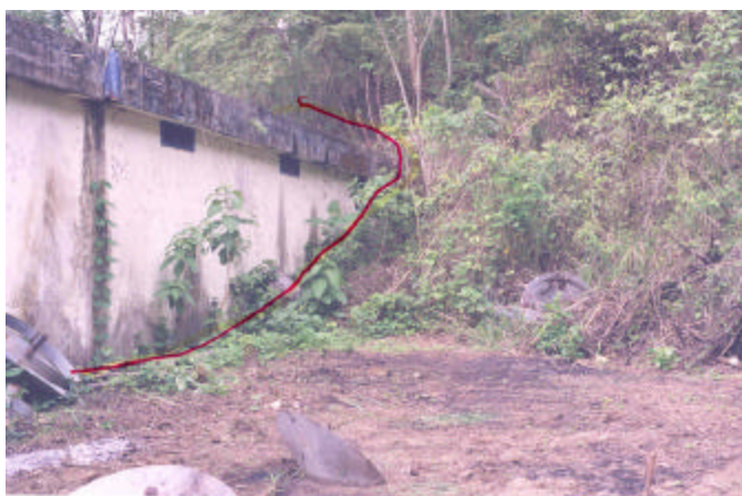
Foto 16 Deslizamiento de la ladera en el tanque de 5,000 m 3 de la planta de Guáramo Sector tanque de distribución de AAPP Guáramo. Febrero 2000. Fuente: Macías, Ramón
