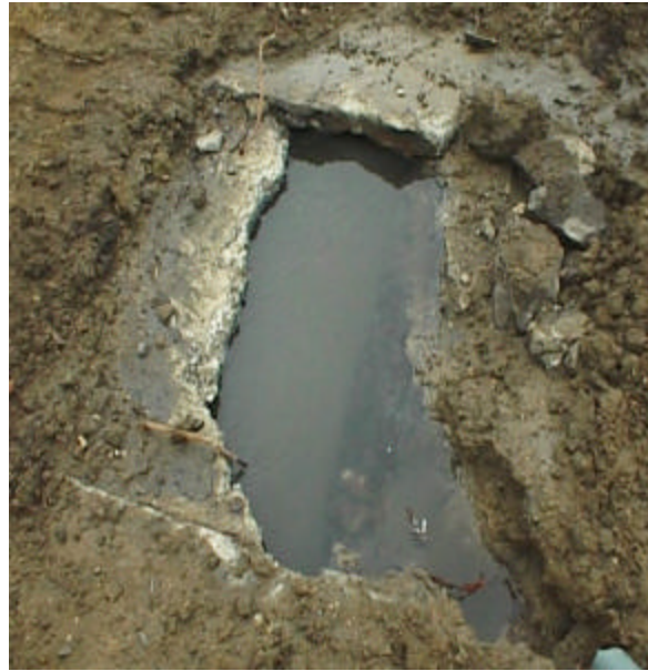
Foto 26. Tubería de aguas servidas destruidas por la acción de los gases sobre la parte superior del hormigón. Sector: calle Alajuela y Coronel Sabando. Octubre 1999 Fuente: INA-BRONCO, Zambrano, Tito.
