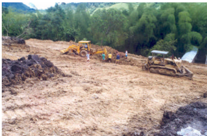
Foto 19. Deslizamiento del cerro. Destrucción de viviendas, carretera y tubería, las que se encontraban a 30 mts. por debajo de la maquinaria. Sector Las Luchas-Boca de Peminche. Abril 1998. Fuente: Herminio, Luis SRAPPH-CRM
