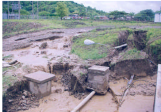
Foto 21. Instalaciones eléctricas en el suelo, cámara de válvulas y tuberías socavadas por el desborde del estero El Zapallo, grietas y sedimentos en las instalaciones de la planta 4 esquinas. Sector planta de tratamiento de AA.PP.4 Esquinas. Febrero 1998. Fuente: DCP-CRM Cadena LC.
