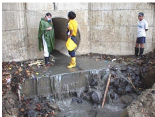
Foto 22. Descarga de agua de lluvia, se observa el color del agua servida producto de las conexiones clandestinas, y los desechos acumulados en la boca del desagüe, no existe ningún elemento para proteger el ingreso de las aguas del Río. Sistema de Porto viejo - Alcantarillado sanitario y de aguas de lluvia (AA.LL). Sector : Callejón Allende- Río Portoviejo. Julio 1999. Fuente: INA-BRONCO, Zambrano, Tito.
