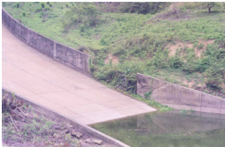
Foto 15. Represa de Poza Honda, se puede observar parte del cuenco amortiguador izquierdo destruido. Sector Embalse de Poza Honda. Febrero 2000. Fuente: Macias, Ramón
