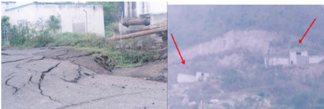
Foto 18. En la primera imagen se aprecia el inicio de los deslizamientos de los tanques de reserva en el mes de marzo del 2000 y en la otra Foto el estado y ubicación de los tanques de reserva en junio del 2000, se aprecia claramente la magnitud del deslizamiento. Sector tanques de reserva Loma Blanca. Junio 2000. Fuente: Macias, Ramón
