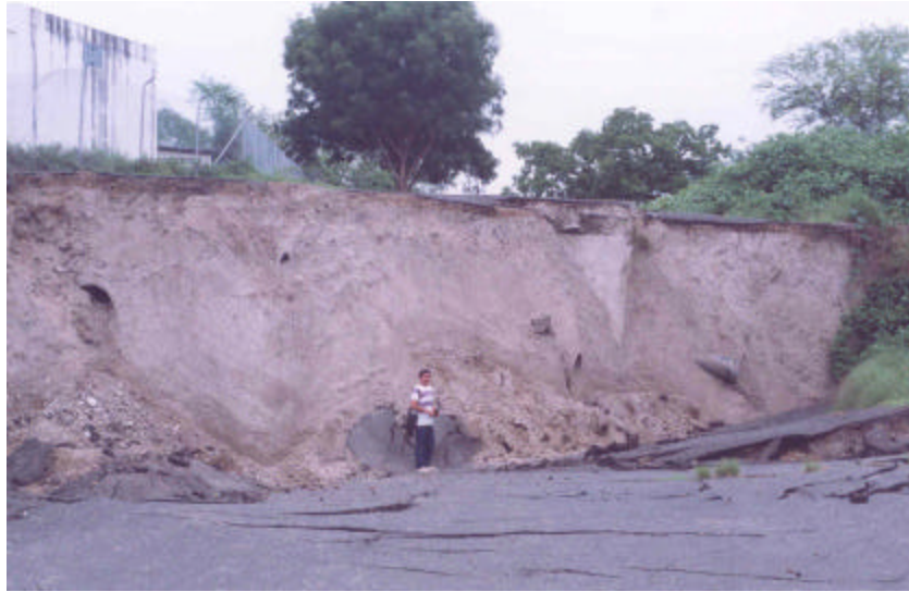
Foto 17. En la imagen se aprecia la ubicación de potable de 5,000 m 3 y 1,600 m 3 en Loma Blanca. Sector tanques de reserva Loma Blanca. Marzo 2000. Fuente: Macias, Ramón
