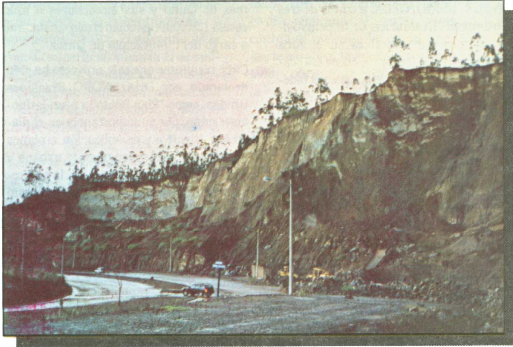
Anexo 1b.- Problemas de inestabilidad de suelos por explotación ilegal de canteras y en condiciones antitécnicas sin normas de protección ambiental. (Canteras vía Simón Bolívar).
