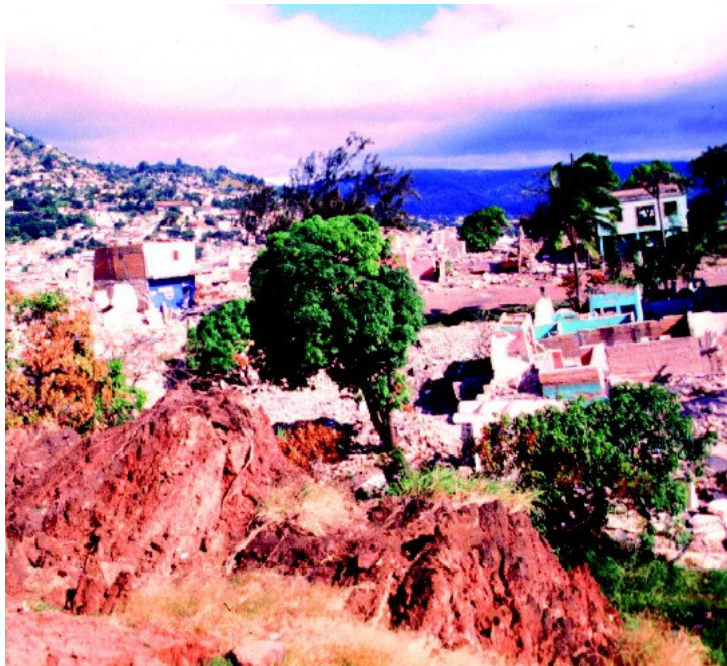
Figura 5: Parte de la colonia el Soto, destruida por el deslizamiento. Observe la rotación con cabeceo hacia atrás indicado por el árbol.
