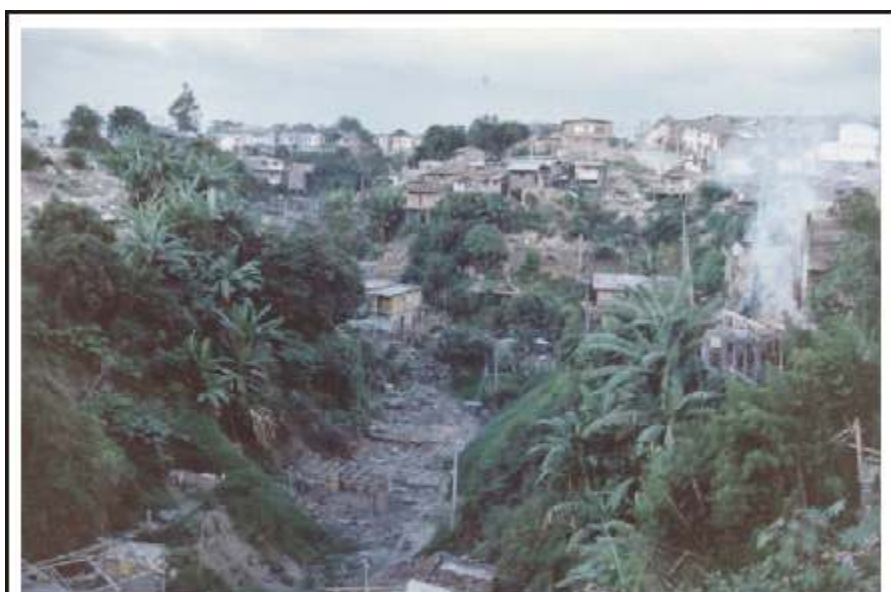
Deslizamiento Barrio Santander Armenia, Quindío, Colombia
