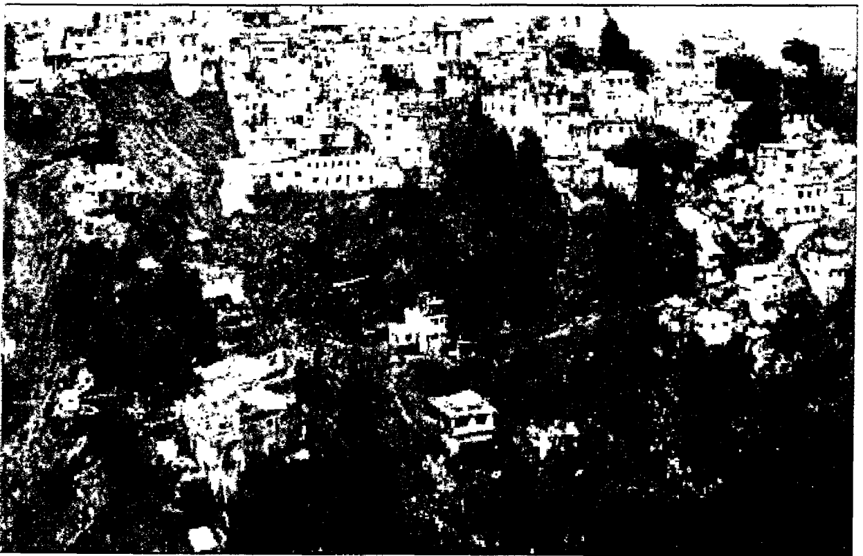
En esta fotografía se puede observar cómo un flujo destruyó algunas construcciones que estaban en la ladera en la colonia Juárez, en Teziutlán, Puebla.
