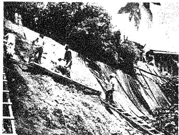
Conformación de talud y siembra de zacate vetiver. SE PROHIBE BOTAR BASURA EN ESTE LUGAR
