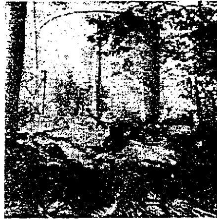
FOTO N° 4.3.1.2 PELIGRO DE COLAPSO DE TANQUE POR SOCAVACIÓN
