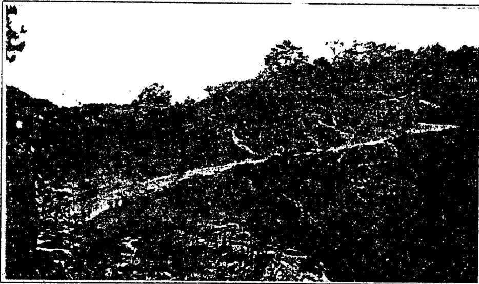
**Figura 10.4.** Vista parcial de la carretera Arimany-Santa Cruz Chinautla, construida en la ladera de un cerro sobre depósitos volcánicos. Obsérvese el corte de terreno que tiene más de 3 metros de altura. Vista al sureste.
