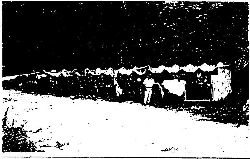
Figura 6.12. Estado actual del edificio del Juzgado en Santa Cruz Chinautla, donde la licuefacción permitió el hundimiento casi total del edificio.
