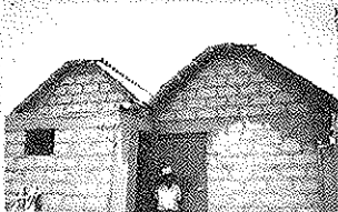
Detalle de bloqueta, vigas, tímpano y cobertura
