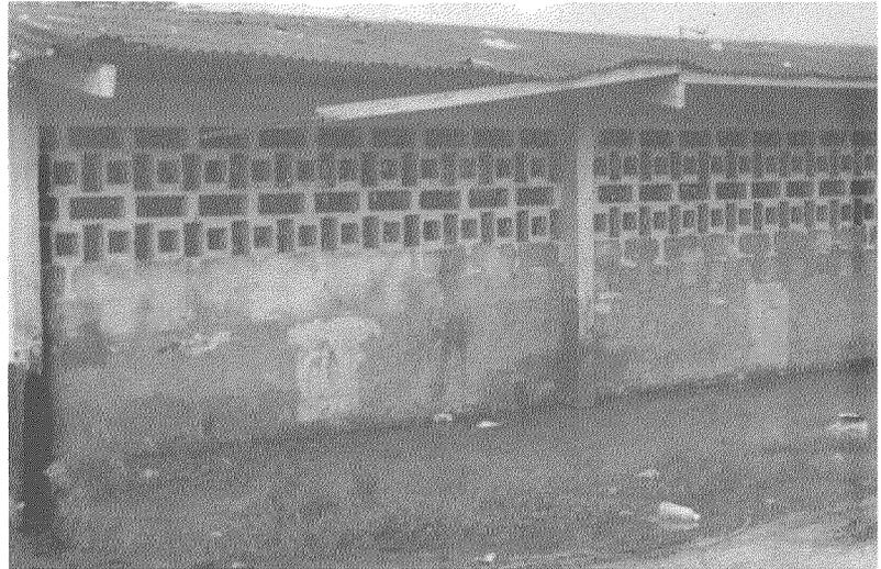
Las medidas de mitigación que requiere la escuela Rafael Marín Valverde de Urbina Jado - Guayas, son varias: colocación de relleno, pavimentación, reconstrucción y elevación de las cubiertas, construcción de cunetas, reconstrucción de instalaciones sanitarias, entre otras.
