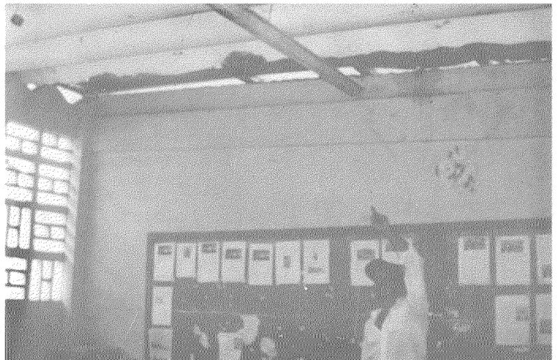
En muchas escuelas hace falta sustituir las planchas de asbesto por una nueva cubierta de acero galvanizado en las zonas más afectadas
