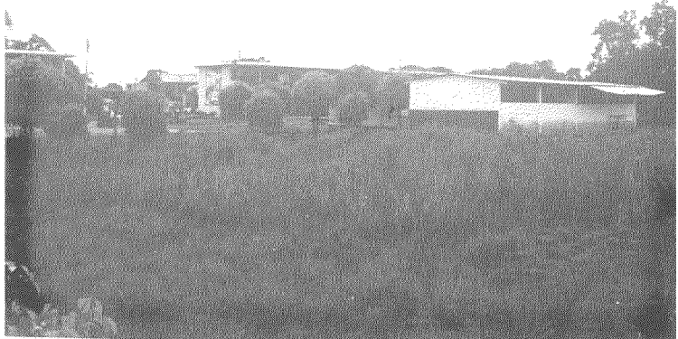
Colegio Otto Arosemena, Milagro - Provincia del Guayas. Se requiere de un dique para la contención de las crecientes del río Milagro que inunda el colegio con aproximadamente un metro de agua.
