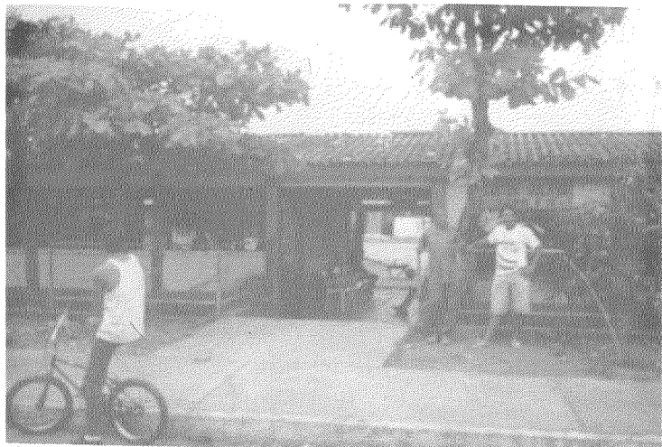
La escuela Simon Bolivar en Calceta-Manabi, se encuentra 50 centímetros por debajo del nivel de la acera. Se debe elevar 20 cm el nivel de los pisos de las aulas, construir cunetas para la canalización de las aguas lluvias y una estación de bombeo para la evacuación de las aguas que se estancan dentro de la escuela
