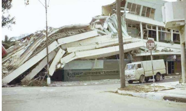
Lámina 4: Daños provocados por el terremoto de Managua, 1972.
