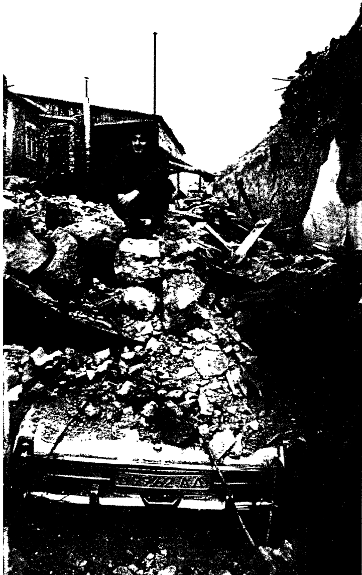
Los primeros edificios en derrumbarse, durante el terremoto de Spitak (Armenia), en 1988. fueron las nuevas viviendas construidas en breve tiempo.
