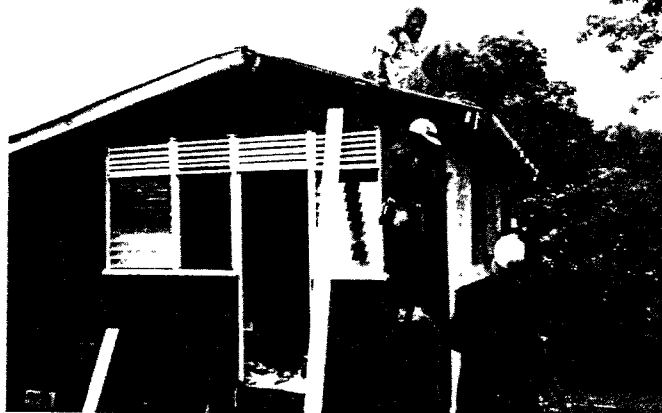
Operarios de Dominica reforzando un tejado antes del huracán Marilyn, en 1995.
