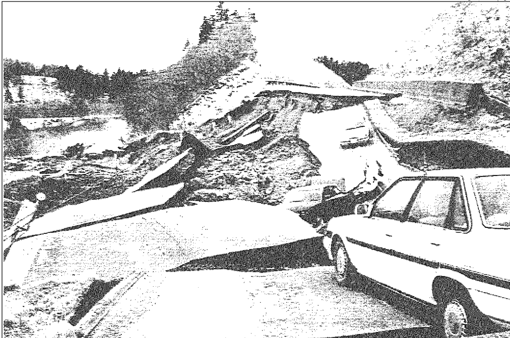
16 Janvier 1993: Véhicules sur une autoroute nationale détruite, tremblement de terre de Kushiro-Oki. (Photo fournie par Mainichi Shinbun)
